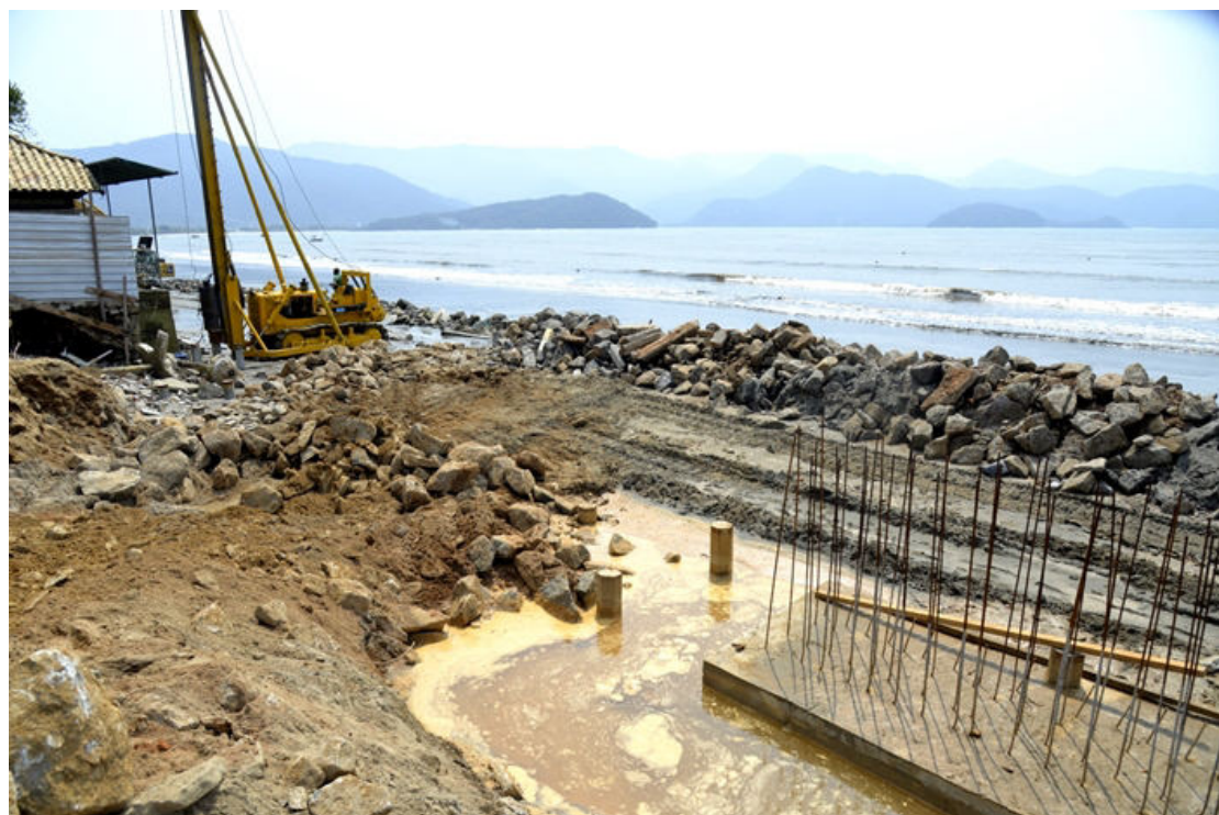
Serviços são executados conforme tábuas de maré
